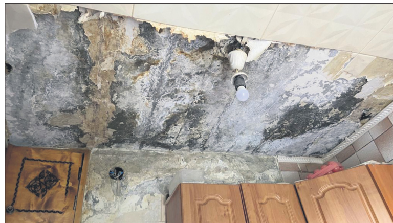
В домах №205 по ул.Ворошилова и №64 по ул.Истомина крыши в ужасном состоянии, после дождя в квартирах и подъездах обваливается штукатурка. ФОТО: ЯНА МИХАЙЛОВА, «МВ».
