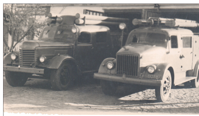
К 1950 году построено пожарного депо, в котором были места для стоянки пожарных автомобилей. ФОТО ИЗ АРХИВА К.КАМЫШАН.
