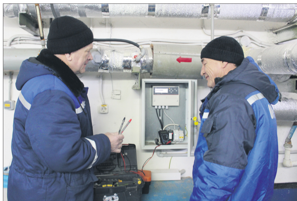
Энергетик А.В.Андрейкин (справа) и электрослесарь А.П.Высоцкий проводят контроль давления и температуры теплоносителя при выходе из котельной. ФОТО: ГАЛИНА СТРИХАРЧУК, «МВ».
