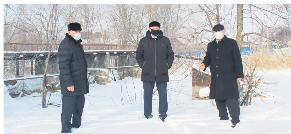
Депутат осмотрел нуждающееся в ремонте гидротехническое сооружение на р.Быстрой. ФОТО: ЮЛИЯ ВАСИЛЕНКО, «МВ».
