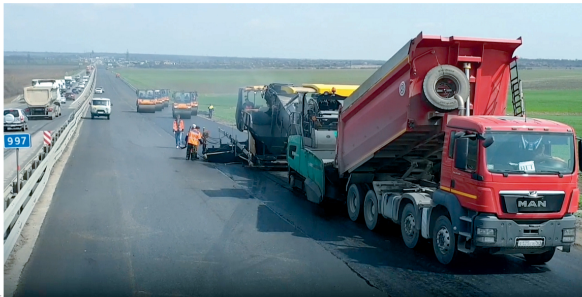
Работы на трассе уже начались
